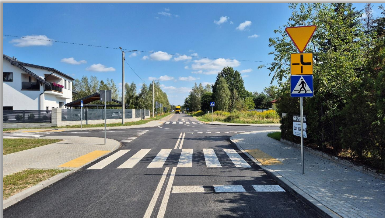
Przebudowa drogi powiatowej nr 2222W Dębe Wielkie – Chrośła – Jędrzenik – Kędzierak od km 0+630 do km 1+355 (725 mb), ul. Przemysłowa, m. Dębe Wielkie
