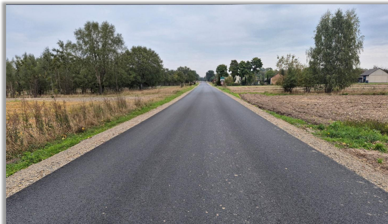
Przebudowa drogi powiatowej nr 2244W Siennica – Cegłów – Kuflew od km 1+972 do km 2+962 (990 mb), gm. Siennica
