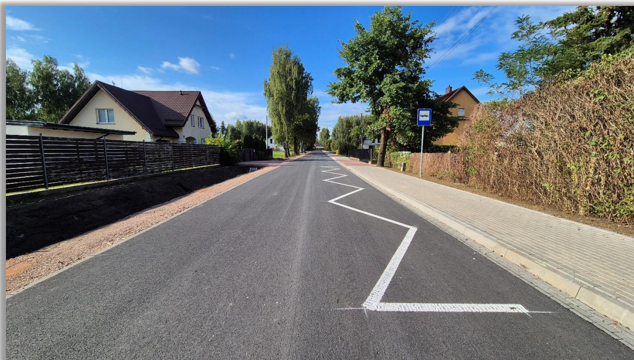
Przebudowa drogi powiatowej nr 2221W Dębe Wielkie – Górki – Poręby od km 2+900 do km 3+217 (317 mb), m. Górki
