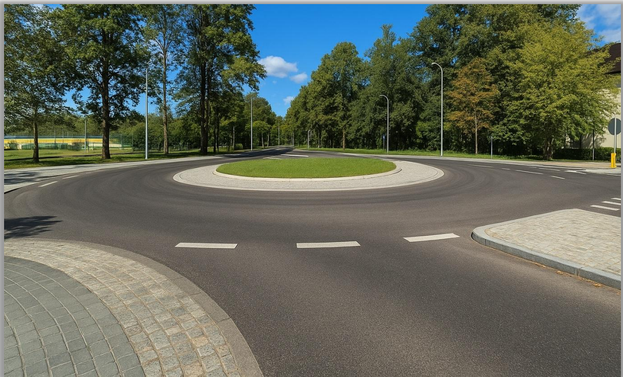
Rozbudowa drogi powiatowej nr 2284W w Sulejówku, budowa ronda na skrzyżowaniu ulic Głowackiego i 3 maja (2024/2025)
